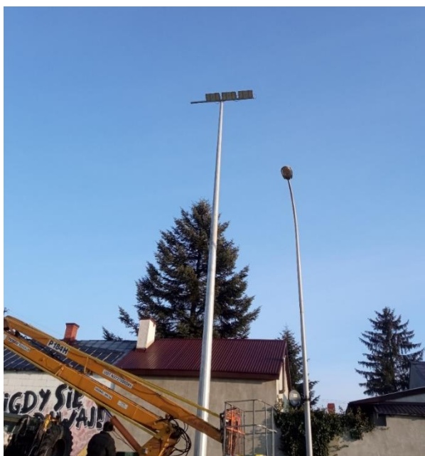
montaż słupów oświetleniowych
