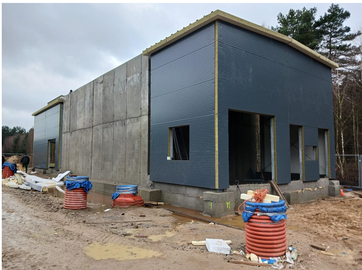
Budynek oczyszczalni ścieków w Grzebowilku stan na koniec grudnia 2023 r.
