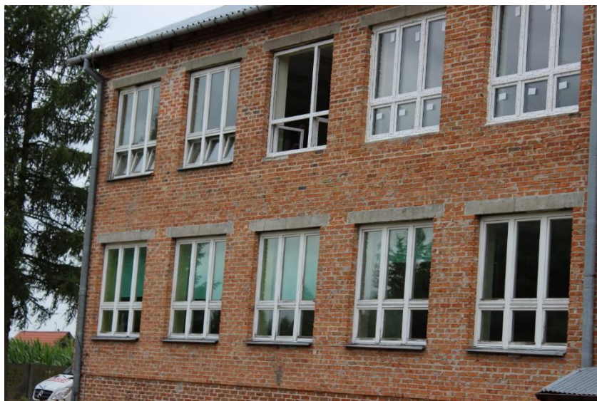
Wymienione okna w budynku szkoły w Żakowie
