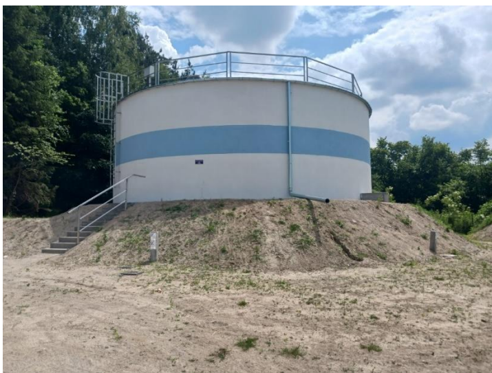
Zbiornik wody czystej
