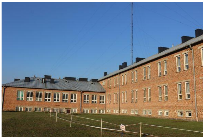
Kominy na budynku Publicznej Szkoły Podstawowej w Żakowie po remoncie
