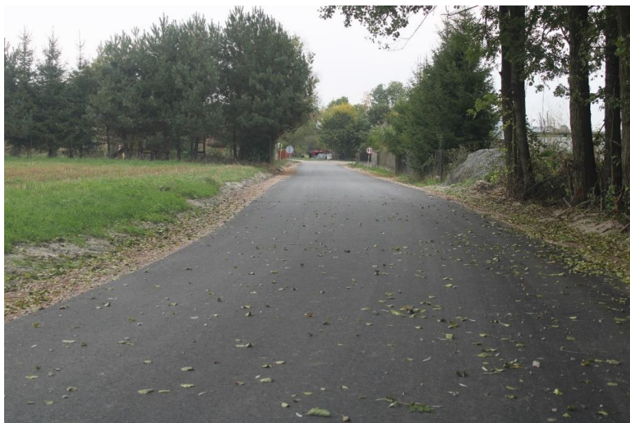
Droga w Nowym Starogrodzie (po przebudowie)
