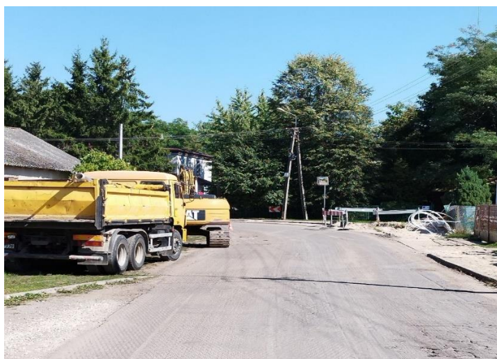
Roboty prowadzone na ul. Mazowieckiej w Grzebowilku
